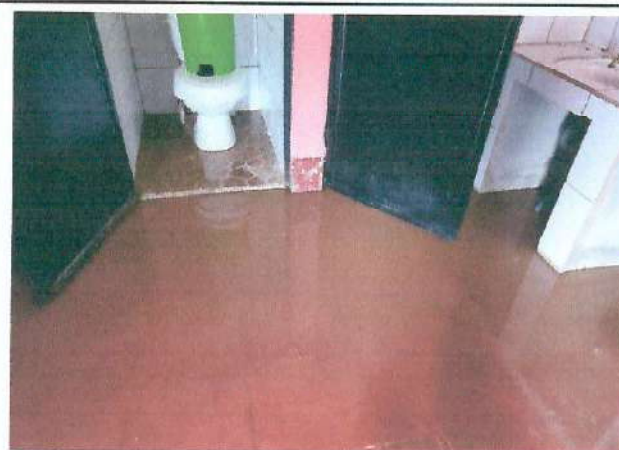
Foto 2: Mejoramiento de servicios sanitarios
